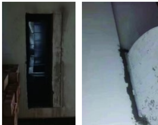
图 4-5 开洞作业与洞口封堵
