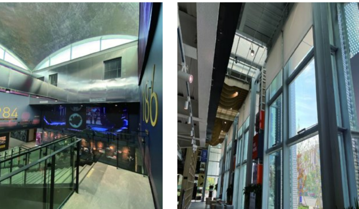
图 2-12 机械排烟口和手动开启排烟窗
