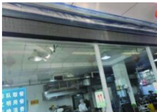
图 1-17 改造完防火卷帘照片
