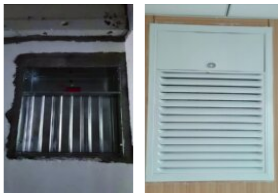
图 4-4 防排烟系统风口安装设置
