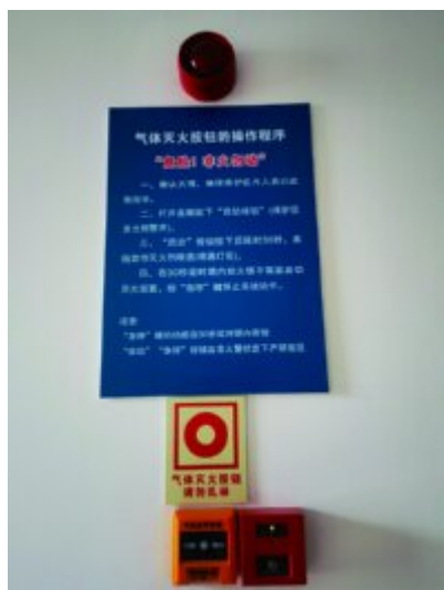
图 1-7 档案室气体灭火及办公室边墙型洒水喷头
