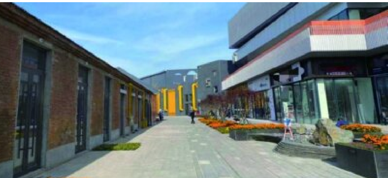
图 2-6 改造后 4m 宽消防车道
