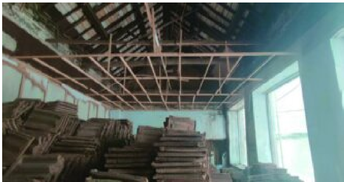
图 6-10 建筑物改造前
