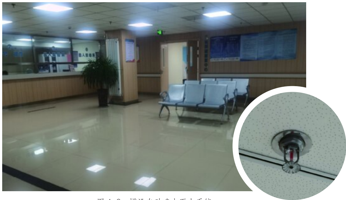
图 4-2 增设自动喷水灭火系统
