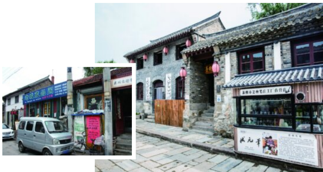
图 7-13 改造前后的小型消防车道
