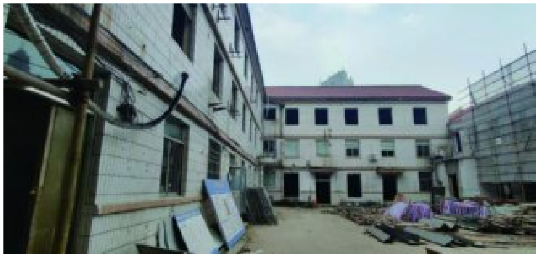
图 6-9 部分房屋贴邻建造，窗口间距较近，不能满足规范防火间距要求
