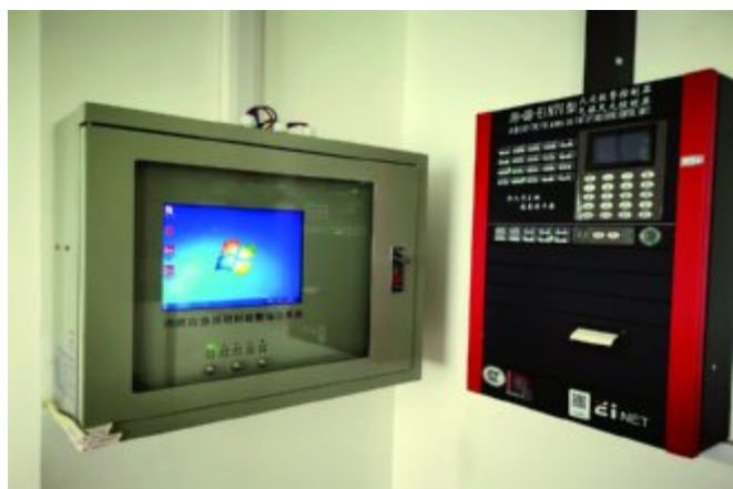
图 1-8 消防应急照明和疏散指示系统、火灾报警控制器
