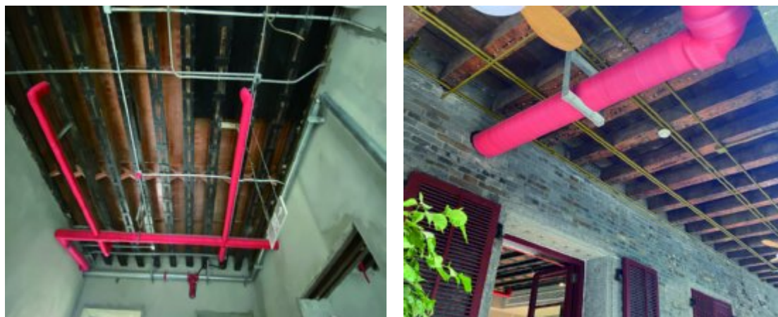
图 7-10 建筑改造消防设施图
