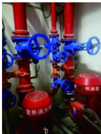
图 1-6 改造后消防水泵
