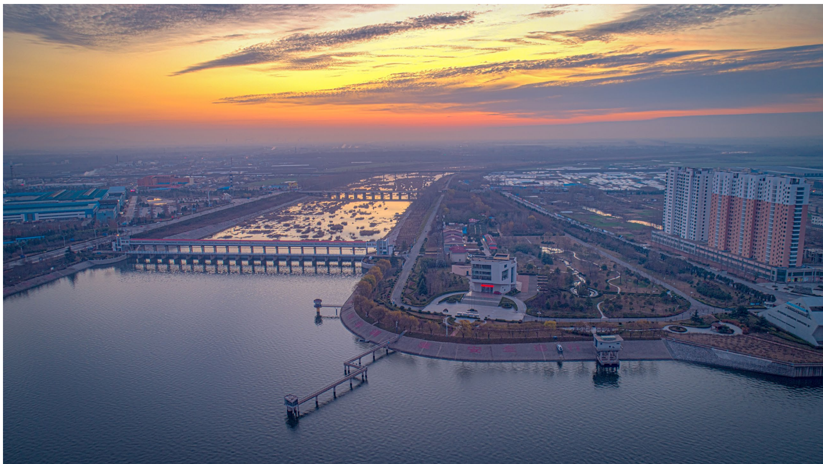
刘道口水利枢纽工程 戚洪宇 摄
