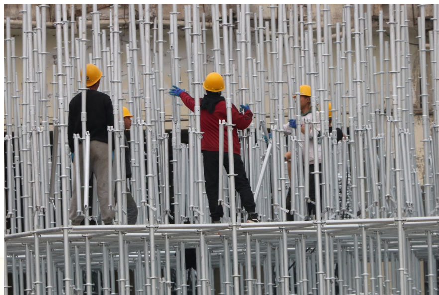
河东北京路大桥建设（组图） 孙晓燕 摄
