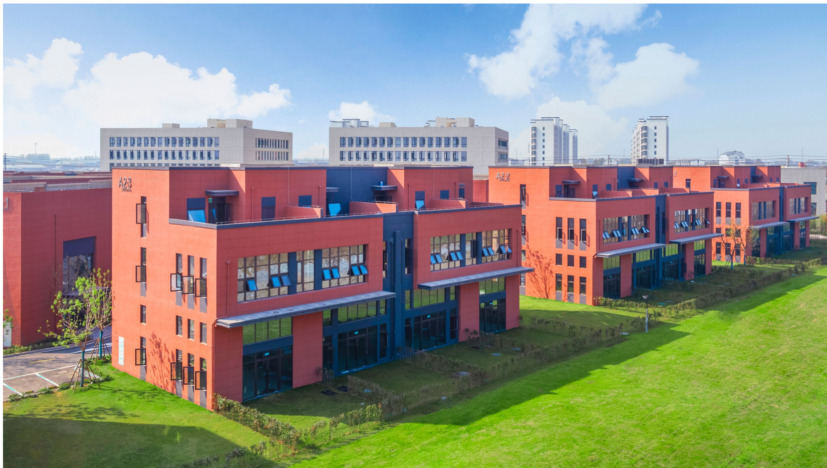
金科临沂智能制造科技城项目
